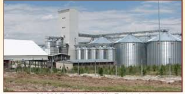
30.000 Tonluk Çelik Silo Tesislerimiz
